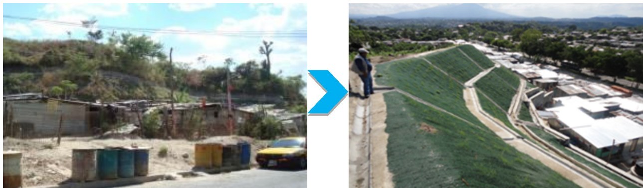
Obras de mitigación en la comunidad Bendición de Dios, Ilopango. Foto de la izquierda muestra el frente de viviendas antes de proyecto y foto a la derecha después de las obras desde la zona alta atrás de las viviendas
